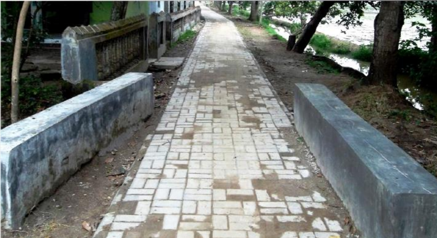
Pembangunan Jalan Lingkungan
